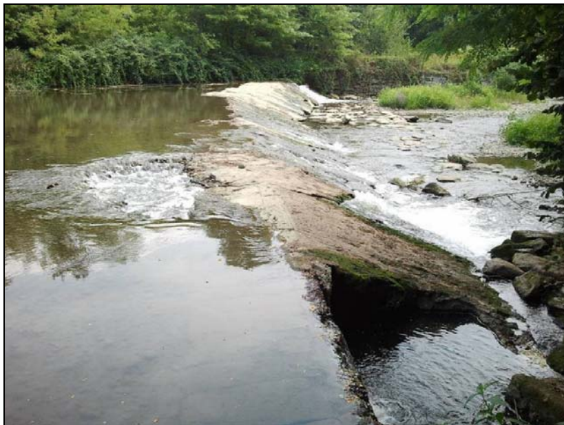
Figura 6.2 – Vista del tratto di scivolo crollato
