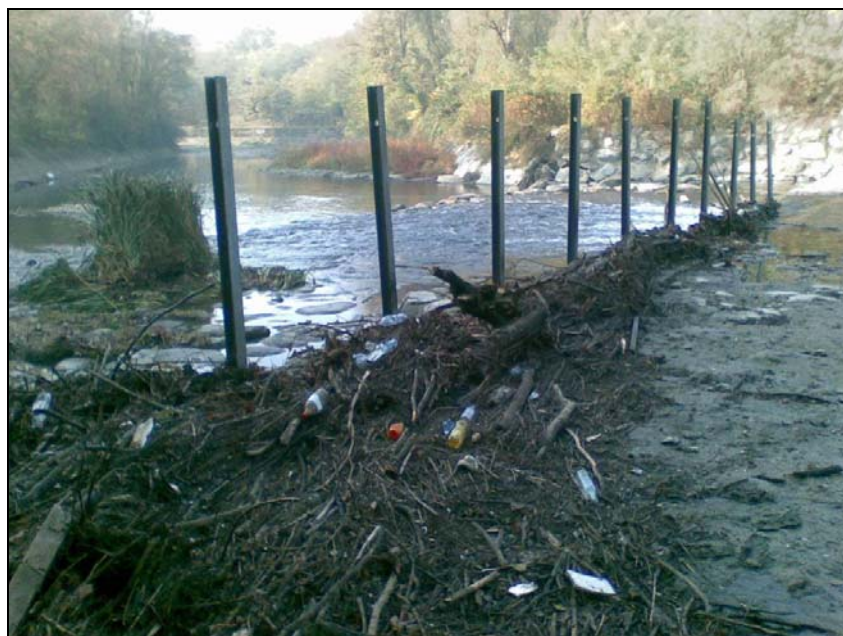
Figura 4.1 – Vista da monte del pettine della briglia sul Lambro
