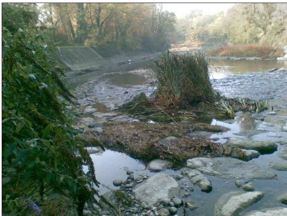
Figura 4.4 – Vista verso valle della sponda sinistra in lastroni e del fondo in massi a valle della briglia
