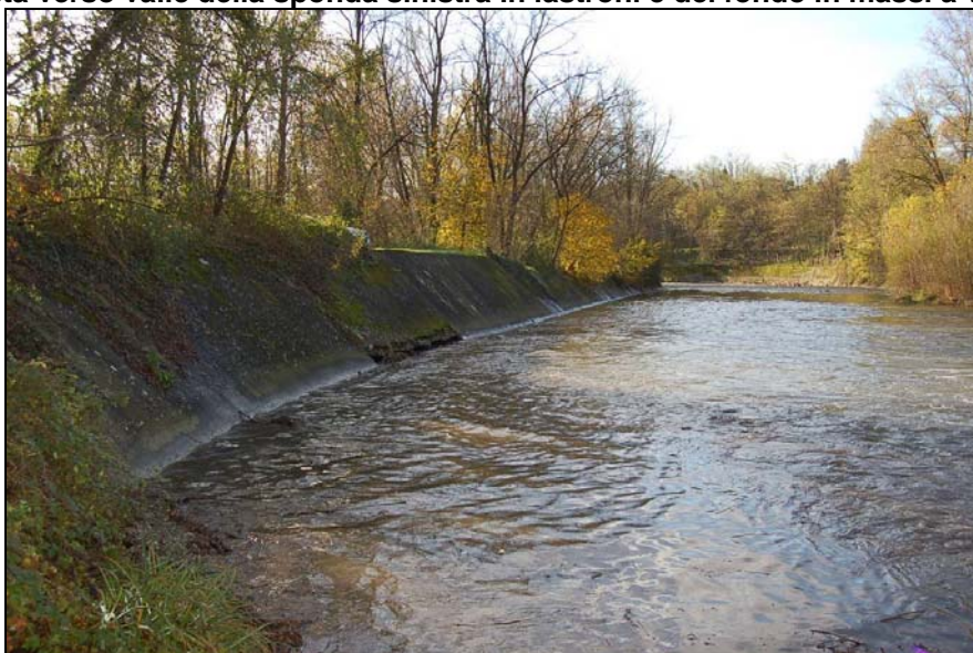
Figura 4.5 – Dettaglio della sponda sinistra in lastroni, con vista di un punto ammalorato
