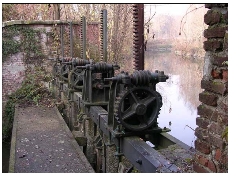
Figura 7.1 – Vista del gruppo di paratoie a monte della traversa
