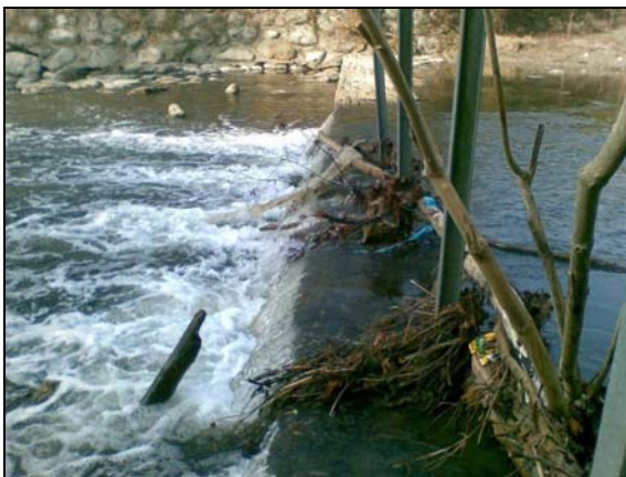
Figura 4.2 – Vista da valle del pettine della briglia sul Lambro
