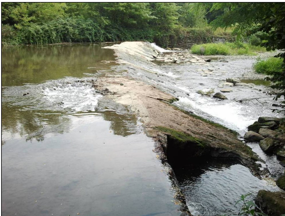
Figura 6.2 – Vista del tratto di scivolo crollato
