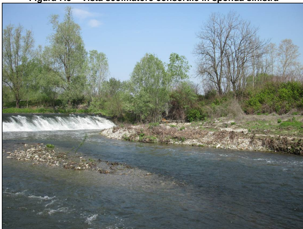
Figura 7.4 – Vista da valle della traversa e della sponda sinistra occupata dai sedimenti
