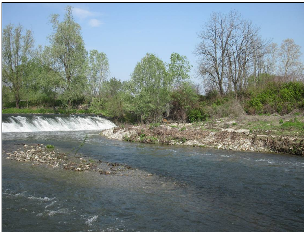
Figura 7.4 – Vista da valle della traversa e della sponda sinistra occupata dai sedimenti
