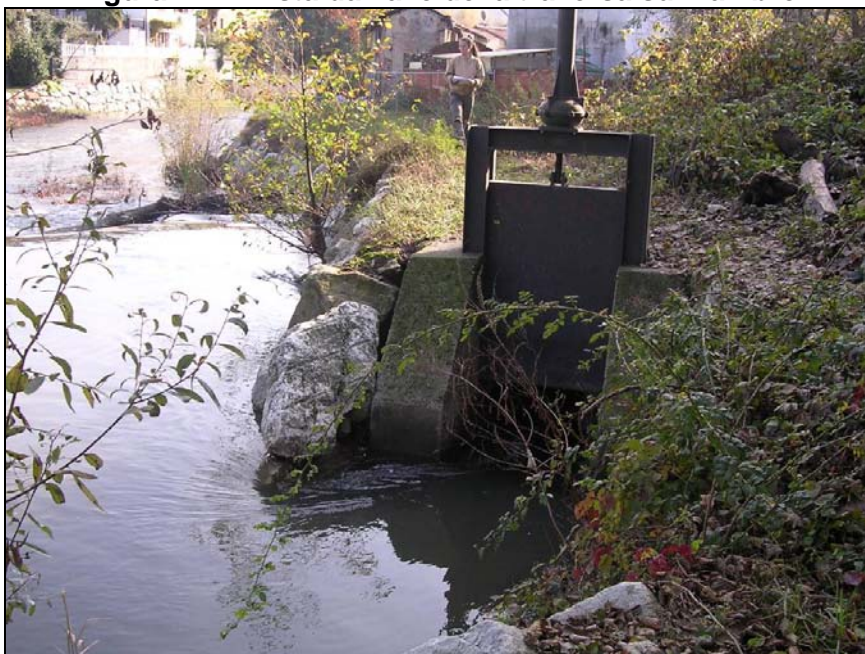
Figura 2.5 – Vista della paratoia di alimentazione della roggia derivata dal Lambro in sponda destra
