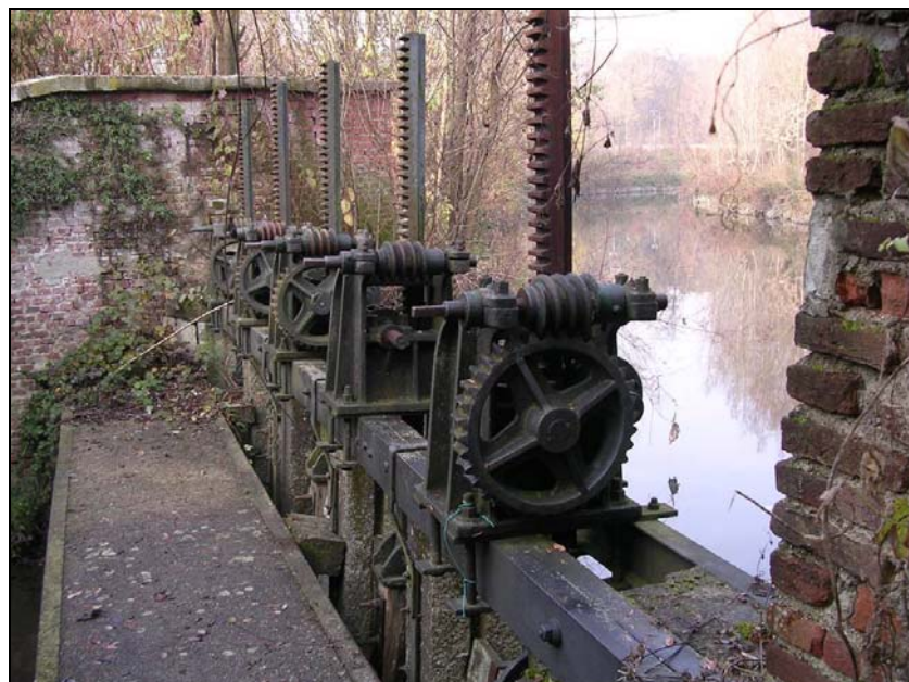
Figura 7.1 – Vista del gruppo di paratoie a monte della traversa
